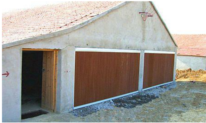
图 2-1 猪舍水帘系统示例图
